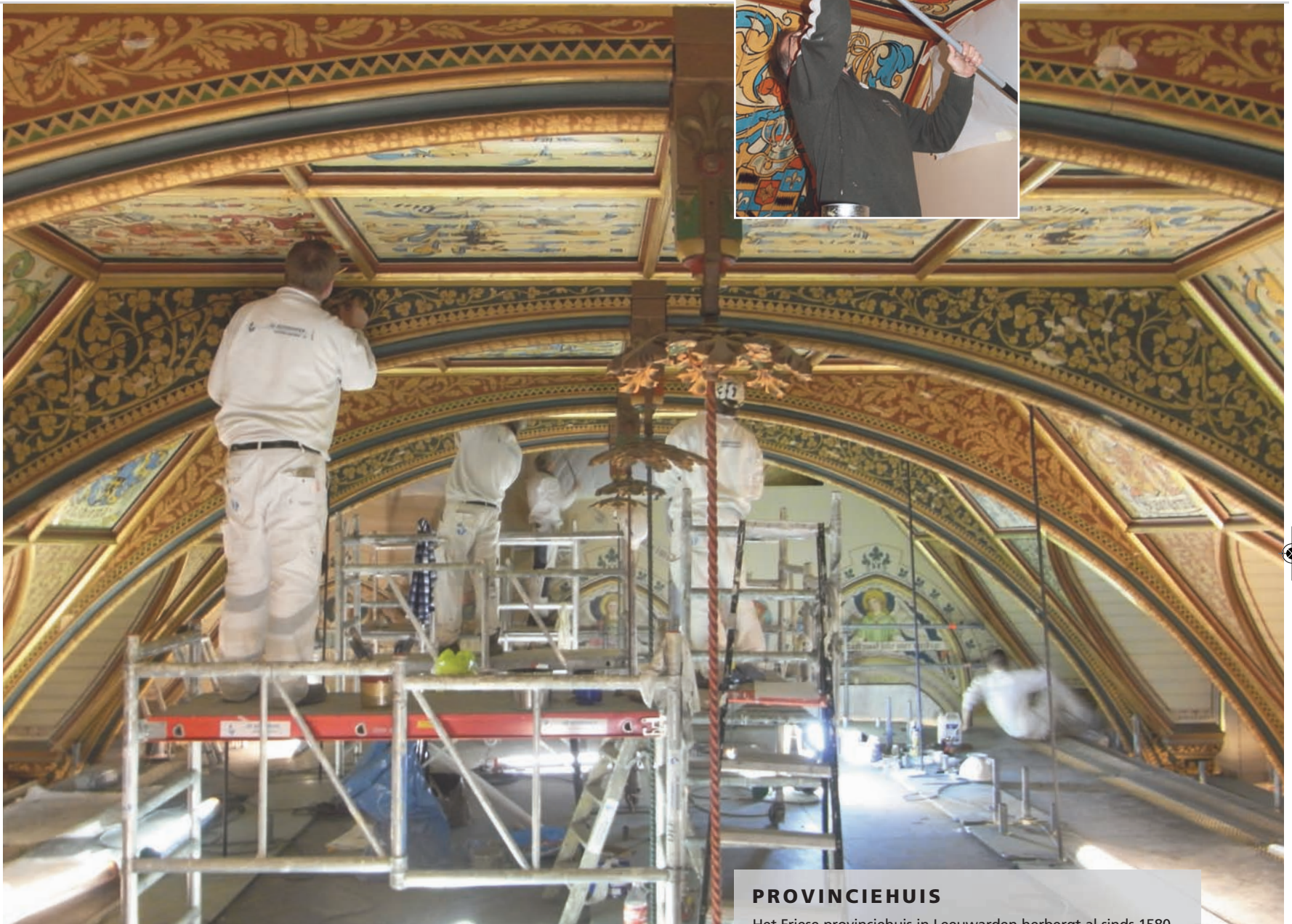
► Zeven restauratiespecialisten werken al wekenlang aan het plafond in de Statenzaal.
